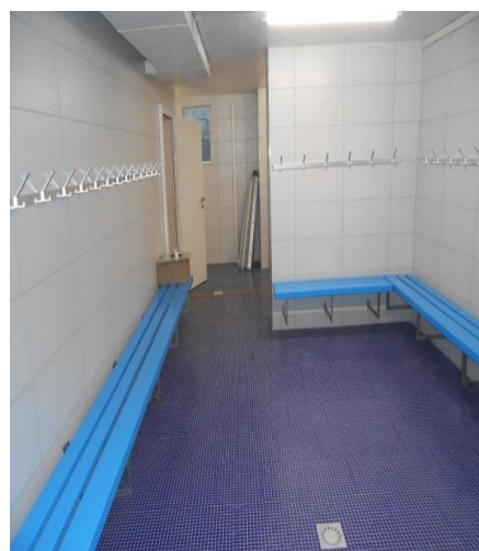
Assainissement du vestiaire Est au sous-sol, carrelage, faïence, fenêtres, peinture, coupe du béton, porte en bois douches, porte métallique accès de la halle polyvalente. Nous avons effectué, comme travaux supplémentaires, le sciage et l'évacuation des murs du sas d'abri pour agrandir les vestiaires et remplacé la porte d'accès à la halle par une porte métallique sans décrochement du mur, avec poignée encastrée : Budget Fr. 30'500.- ; Facturation Fr. 39'105.40.
