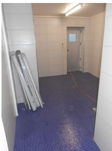
Assainissement du vestiaire Est au sous-sol, carrelage, faïence, fenêtres, peinture, coupe du béton, porte en bois douches, porte métallique accès de la halle polyvalente. Nous avons effectué, comme travaux supplémentaires, le sciage et l'évacuation des murs du sas d'abri pour agrandir les vestiaires et remplacé la porte d'accès à la halle par une porte métallique sans décrochement du mur, avec poignée encastrée : Budget Fr. 30'500.- ; Facturation Fr. 39'105.40.
