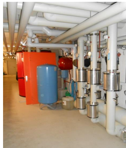
Modification de l'arrivée du chauffage à distance et installation d'un échangeur sur le groupe primaire chauffage : Budget Fr. 33'000.- ; Facturation Fr. 26'094.35.
