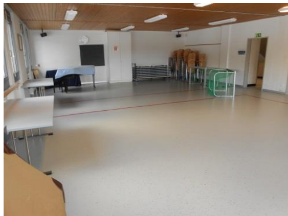
Salle des répétitions, remplacement du linoléum par un sol sans joints : Budget Fr. 23'000.- ; Facturation Fr. 23'000.-
