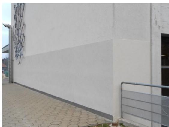
Réfection du bas des façades côté Epinettes et retour St-Sébastien, avec bande métallique de soubassement : Budget Fr. 9'000.- ; Facturation Fr. 3'900.-
