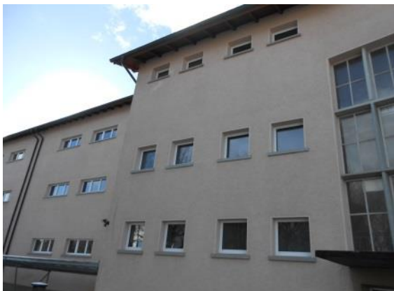
Remplacement des fenêtres des pièces annexes, façades nord, locaux sanitaires, studios : Budget Fr. 24'500.- ; Facturation Fr. 12'874.15
