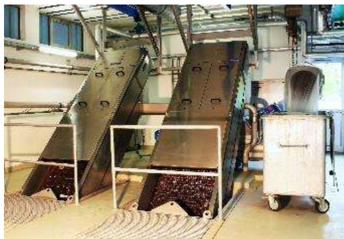
Installation du dégrillage
